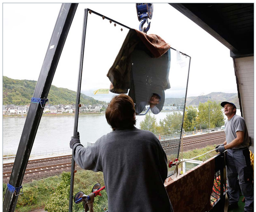
Einbau von schalldämmenden Fensterscheiben in einem Fachwerkhaus am Mittelrhein
