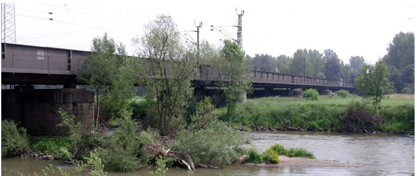
Die Auswirkungen von zusätzlichen Brückenpfeilern in der Sieg waren Bestandteil der Untersuchungen im Rahmen der Umweltverträglichkeitsstudie.
