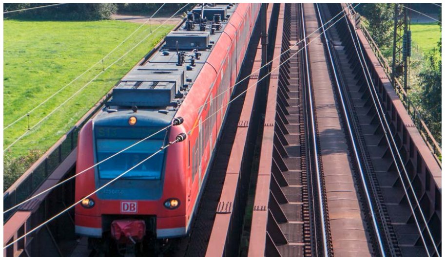
Westlich bzw. stromabwärts der bestehenden Siegbücke wird zusätzlich eine neue eingleisige Brücke gebaut.
