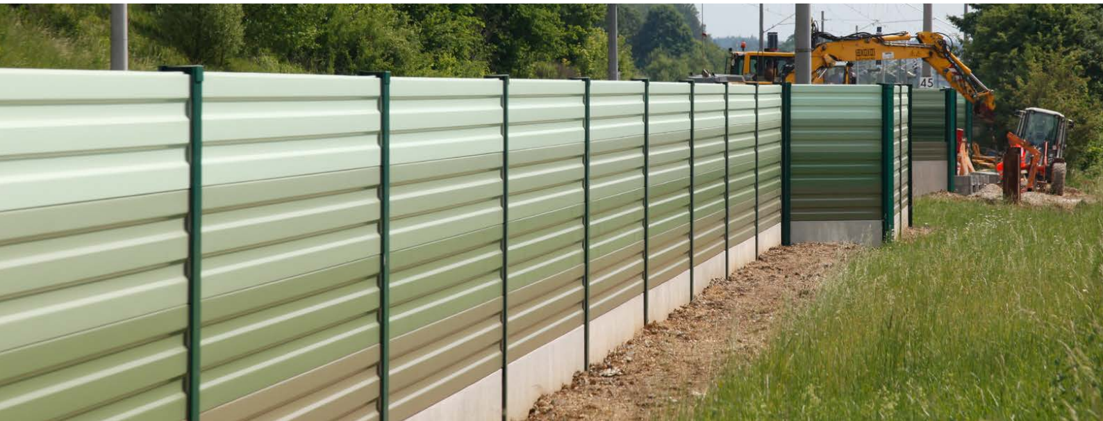
Beispiel einer Schallschutzwand aus Aluminiumelementen
