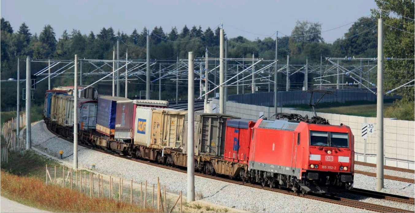
Schallschutzwand bei Hattenhofen
